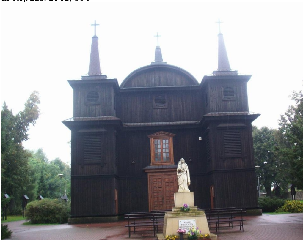
10. Kampinos, kościół par. pw. Wniebowzięcia najświętszej Maryi Panny, 1773-1782, nr Rej. zab. 1041/604
